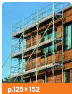
ÉCHAFAUDAGES DE FAÇADE ET MULTIDIRECTIONNEL
