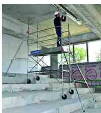
AC200 - Installation en dénivelés
