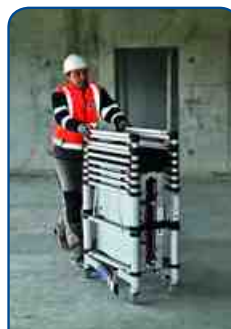
Structure, plancher et plinthes acheminés ensemble sur le chantier
