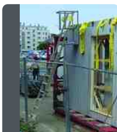
p.81 Travaux sur prémurs API
