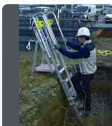
p.84 Accès sécurisé dans les fouilles ACCÈS FOND DE FOUILLE
