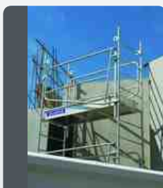
p.85 Travaux/circulation banches AC BANCHE p.86 ENTRE-BANCHE
