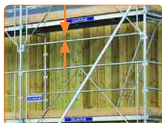
Travée d'accès avec lisse de protection au-dessus du garde-corps.
